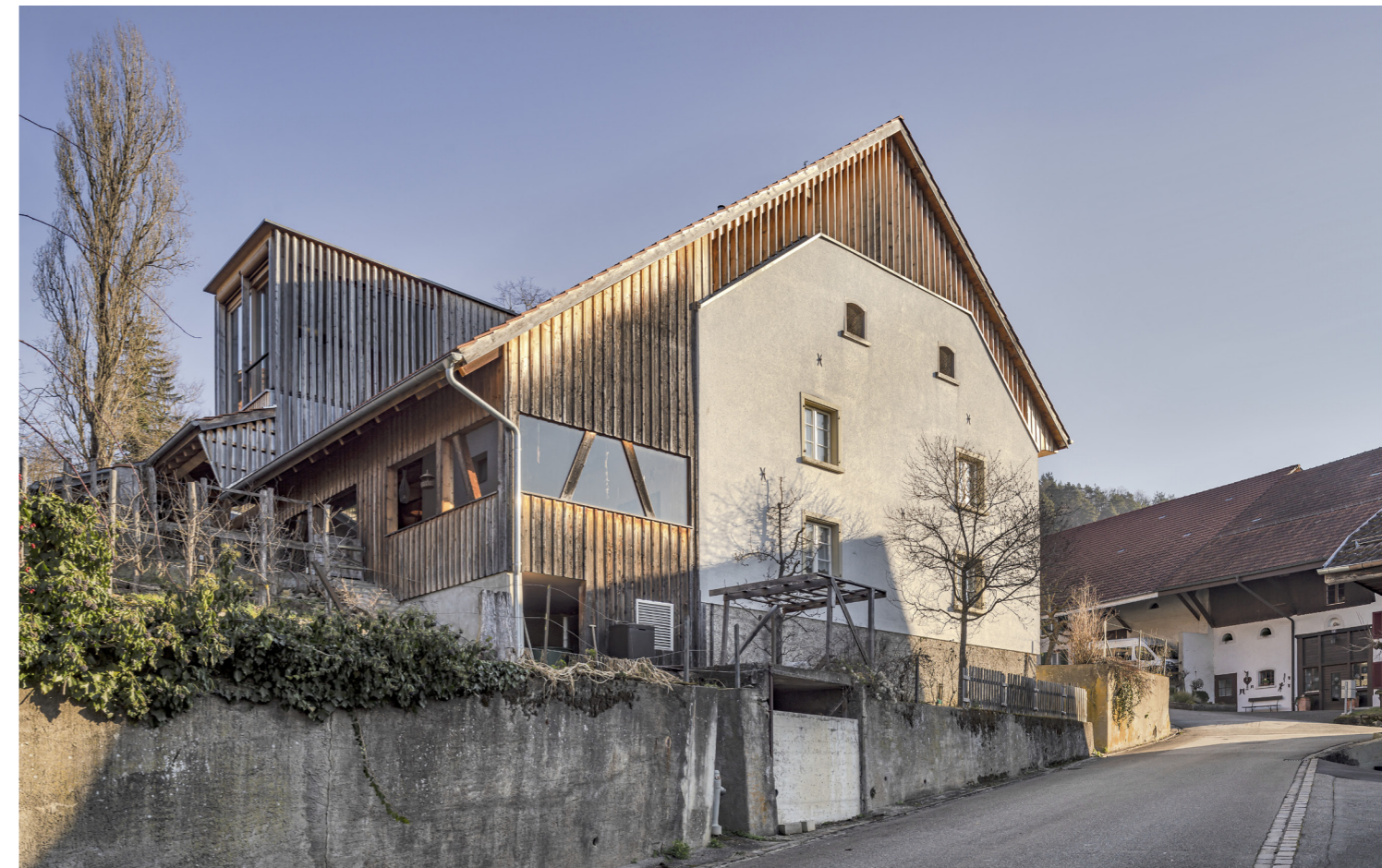
Abbildung 18: Umbau eines Bauernhauses in Elfingen (Quelle: Architekt – Markus Schlempp, Basel; Fotograf – René Dürr, Zürich).
