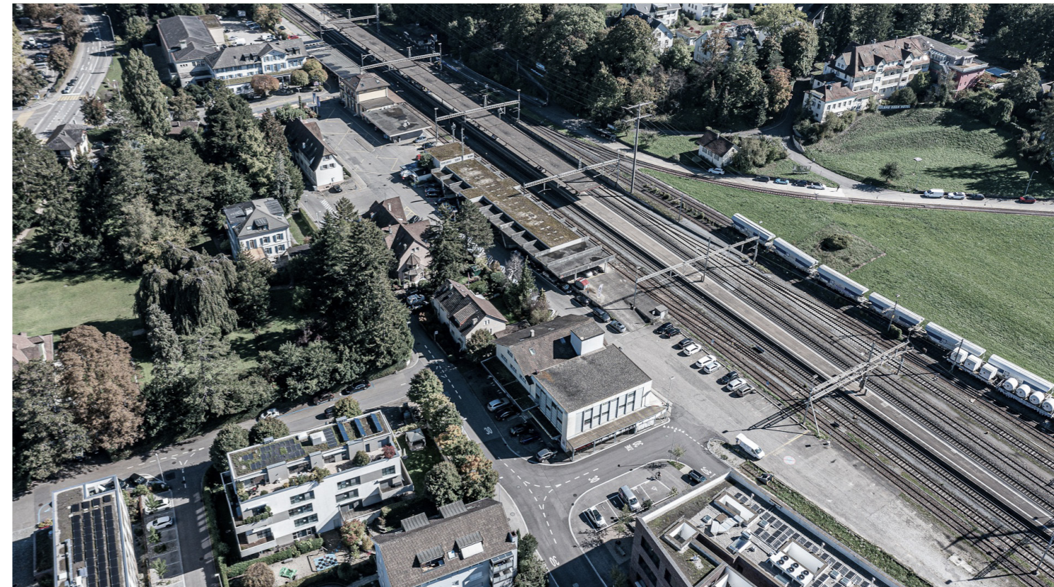
Abbildung 24: Wie auch andere Bahnhöfe im Fricktal soll der Bahnhof Rheinfelden als Mobilitätshub entwickelt werden (Quelle: Neue Mitte Rheinfelden).
