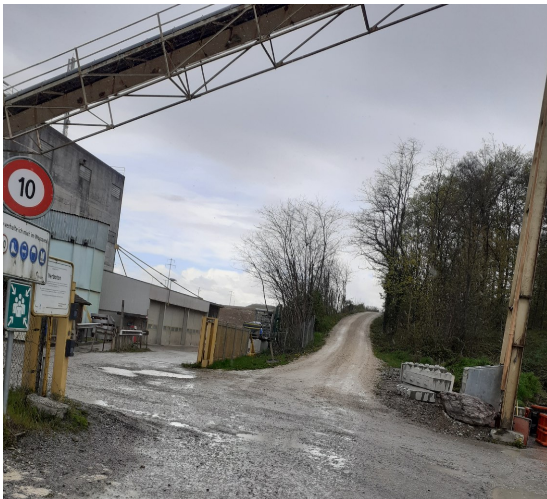
Abbildung 33: Finstergässchen auf dem Betriebsareal (Foto von der Begehung am 13.04.2023)
