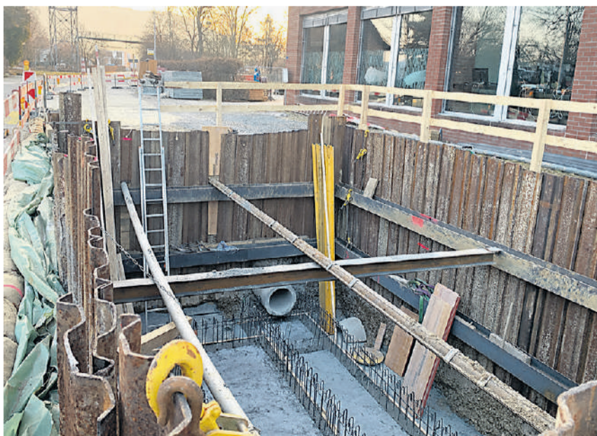
Blick in die Baugrube beim Schulareal Ebnet in Frick.
