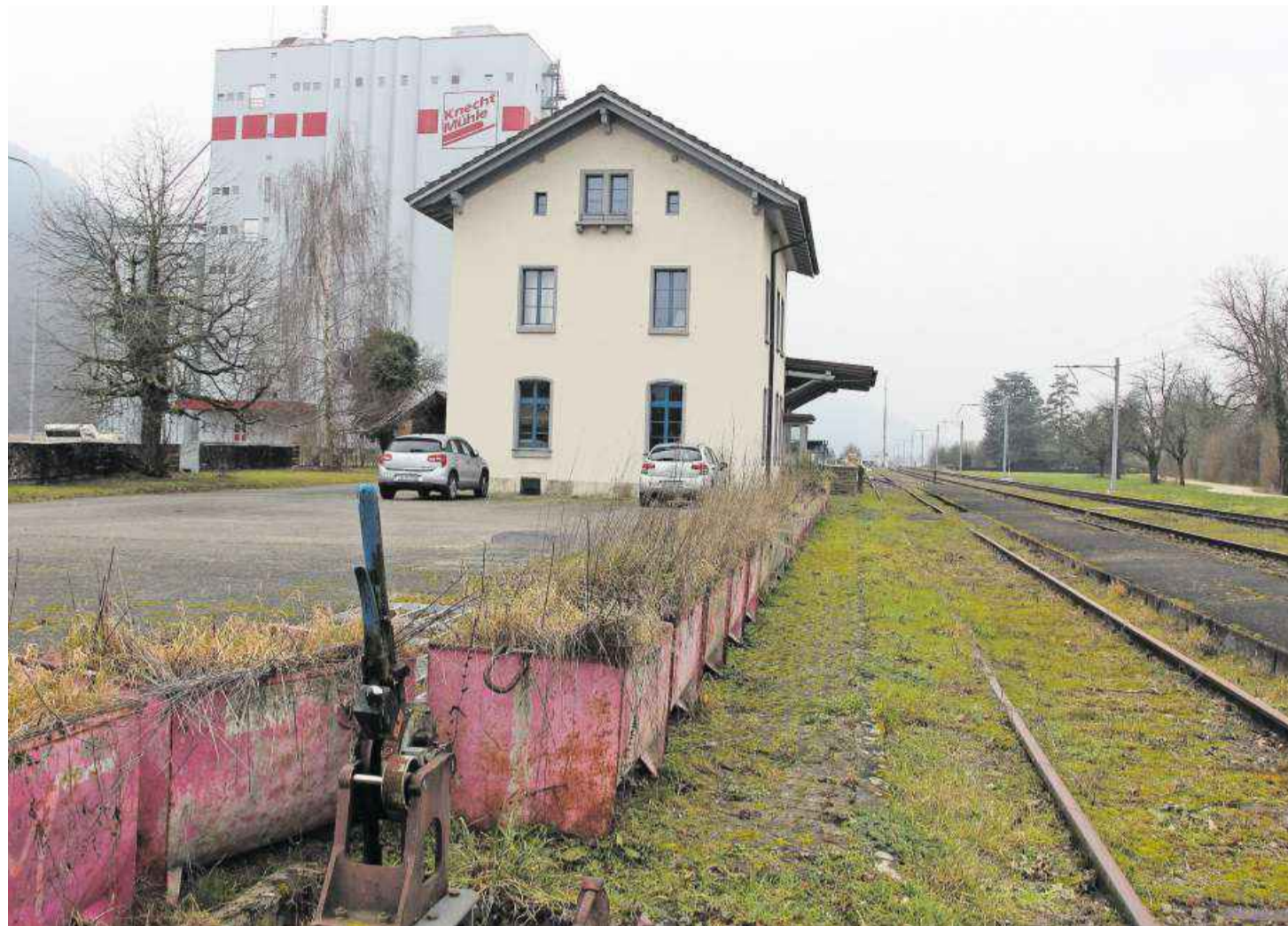
Noch herrscht am Bahnhof Leibstadt gähnende Leere. Dereinst könnten hier aber wieder Passagiere ein- und aussteigen.
