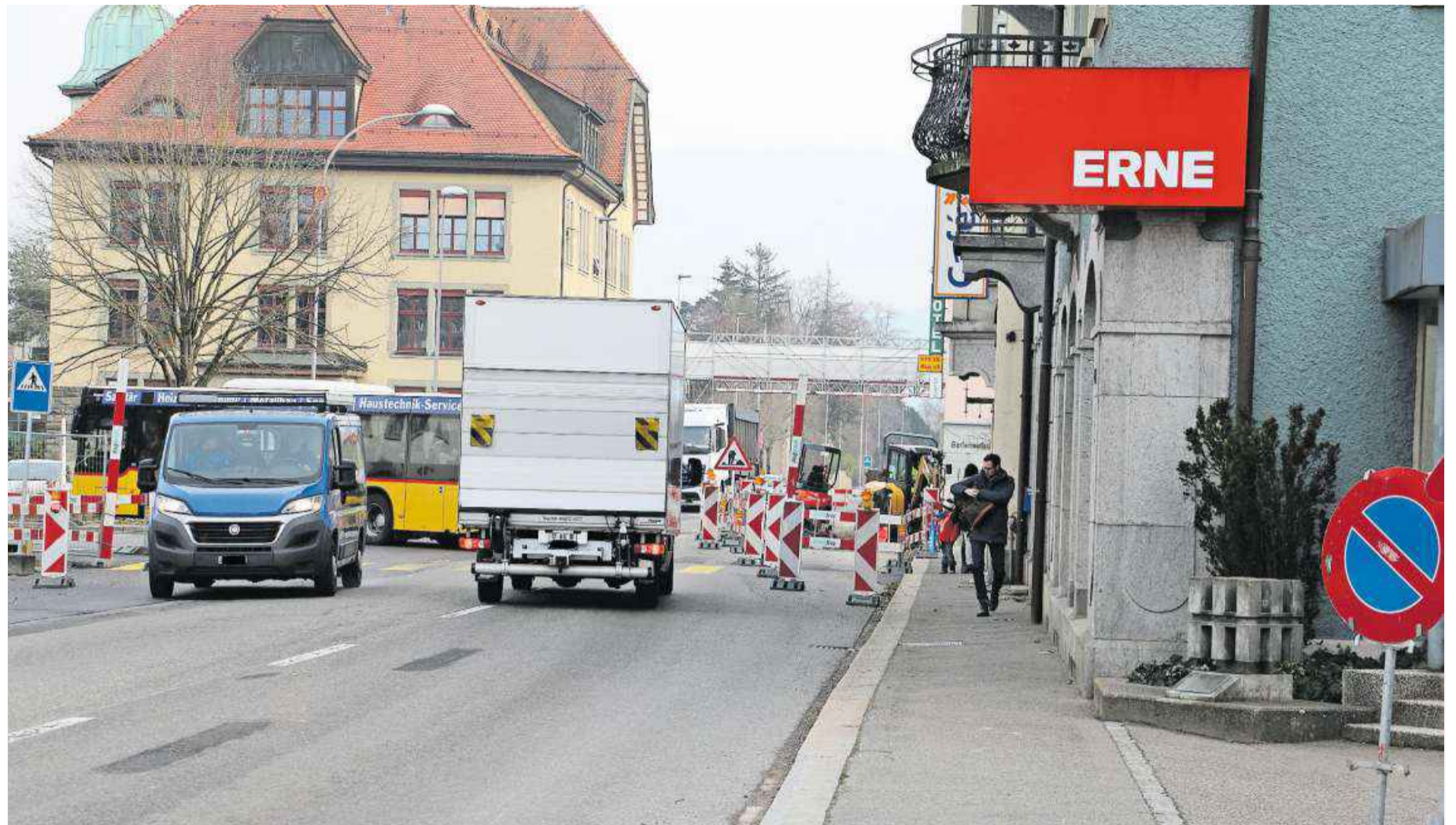
Die Sanierungsarbeiten an der Baslerstrasse in Laufenburg wurden wieder aufgenommen. Im Februar braucht es wieder eine Ampel.
