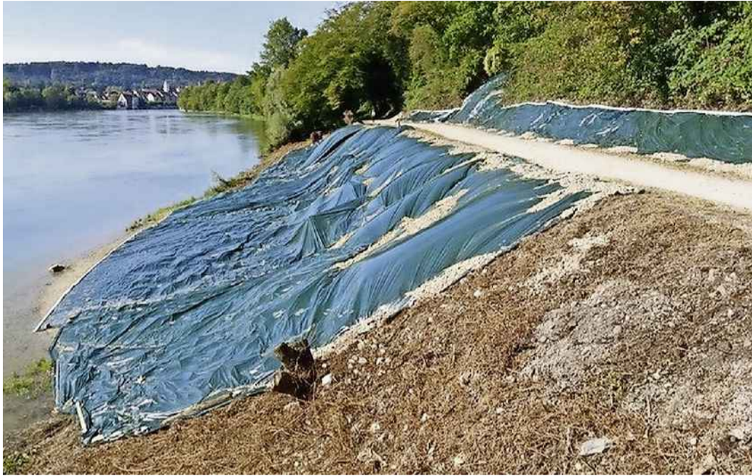
Zur Vergrämung der Eidechsen wurde eine Folie ausgelegt, mit schmalen Gängen, die den Eidechsen eine Abwanderung in teilweise eigens angelegte Ersatzlebensräume ermöglicht. Bild: zvg
