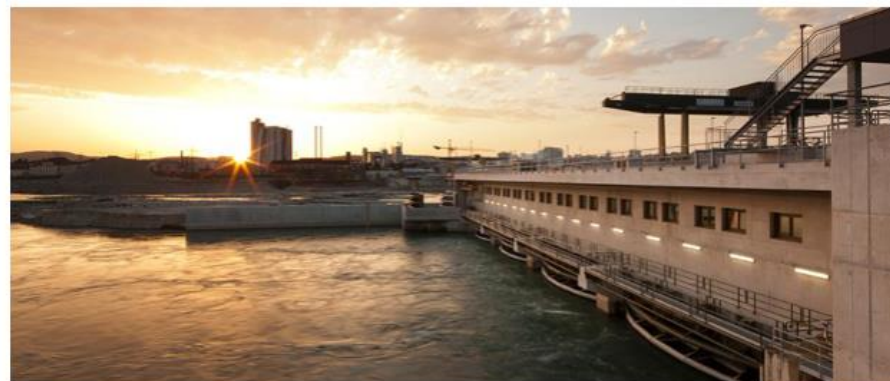
Wasserkraftwerk Rheinfelden - Bild EnergieDienst
